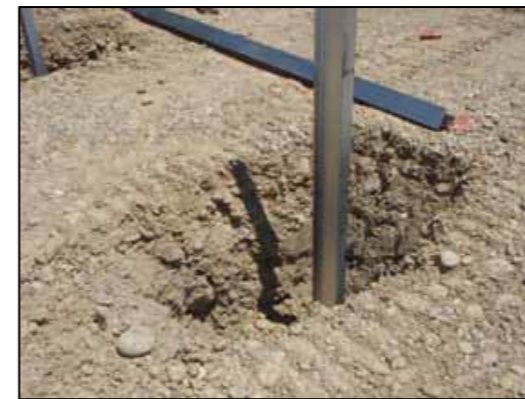
Figure 7 : Types de fondation - pieux battus (Source : Guide MEDDTL 2011 – NCA, 2015)
