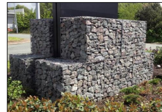
Figure 9 : Exemple de muret en gabion (Source : TCS Geotechnics)
